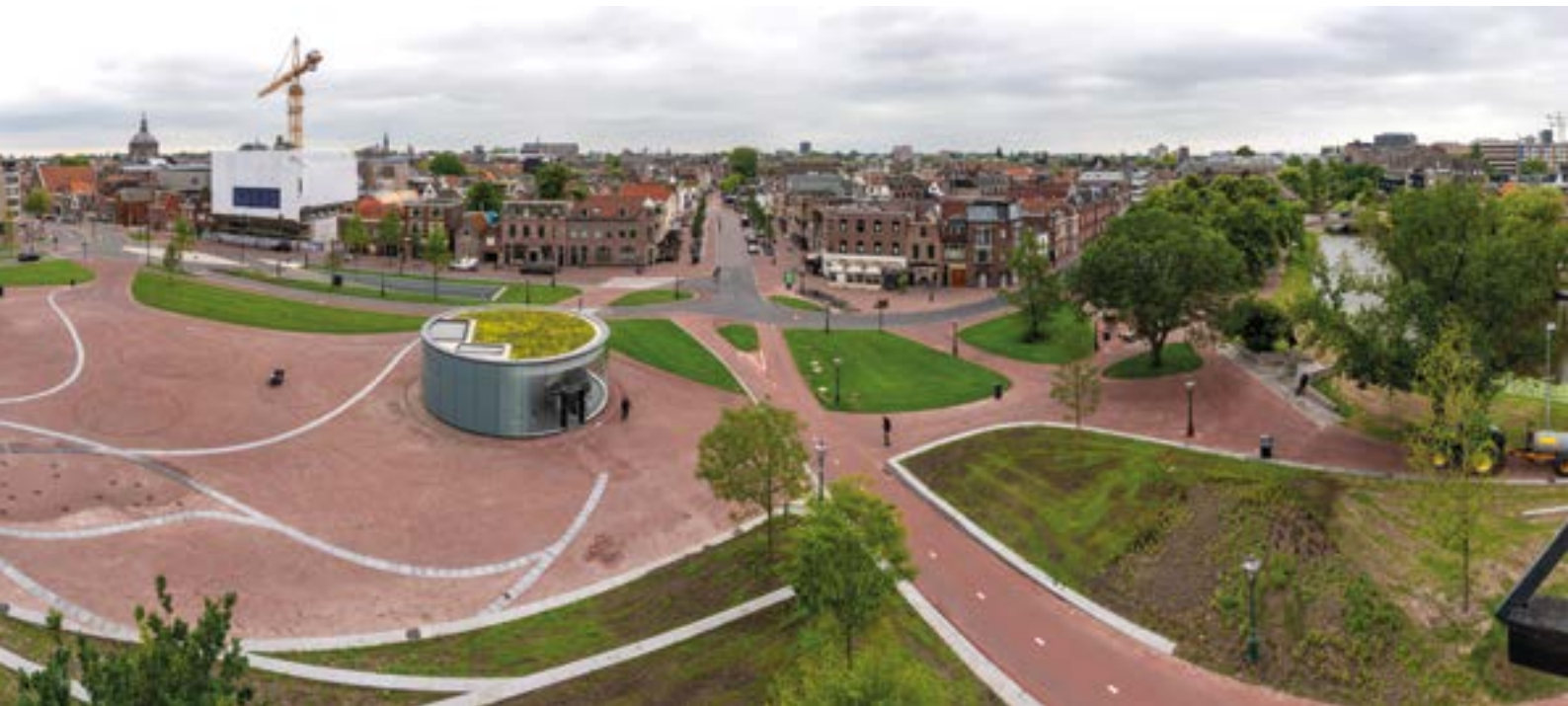
Cultuurplein Lammermarkt, het maaiveld na bouw van de ondergrondse parkeergarage
