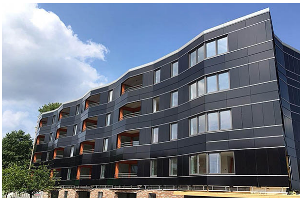
voorbeeld geplaatst op doemee: zonnepanelen zuidgevels
